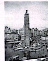
La construcción del Obelisco, 1936.
